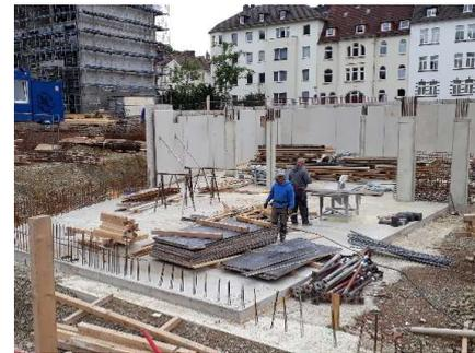
Ein Teil der Innenwände im Tiefgaragengeschoss werden ebenfalls mit Planblöcken erstellt. Die Aufzugswände bestehen aus Stahl-Beton und werden vor Ort geflechtet, eingeschalt und gegossen.
