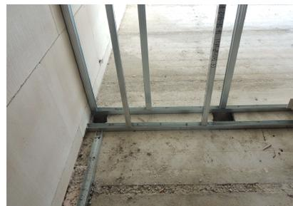
Nach erfolgter Installation der Leitungsführung wurden die Trockenbauwände mit einer mineralischen Dämmung  $d = 7,5$  cm ausgefüllt und jeweils zweifach mit Gipskartonplatten beplankt, siehe Abb. K-70 und K-71. In den Nassbereichen wurden imprägnierte Gipskartonplatten für die Nutzung in Feuchträumen verwendet.
