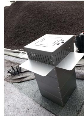
3. Verlegung der Trenn-Schutz-Folie im Bereich der Retentionsbox (siehe Abb. K-59)
