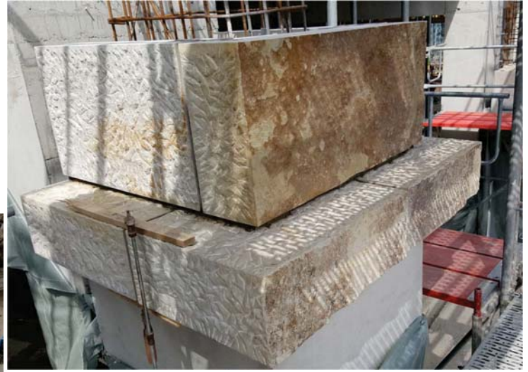
Pfeilermauerwerk auf Sichtbetonstütze im Restaurantbereich
