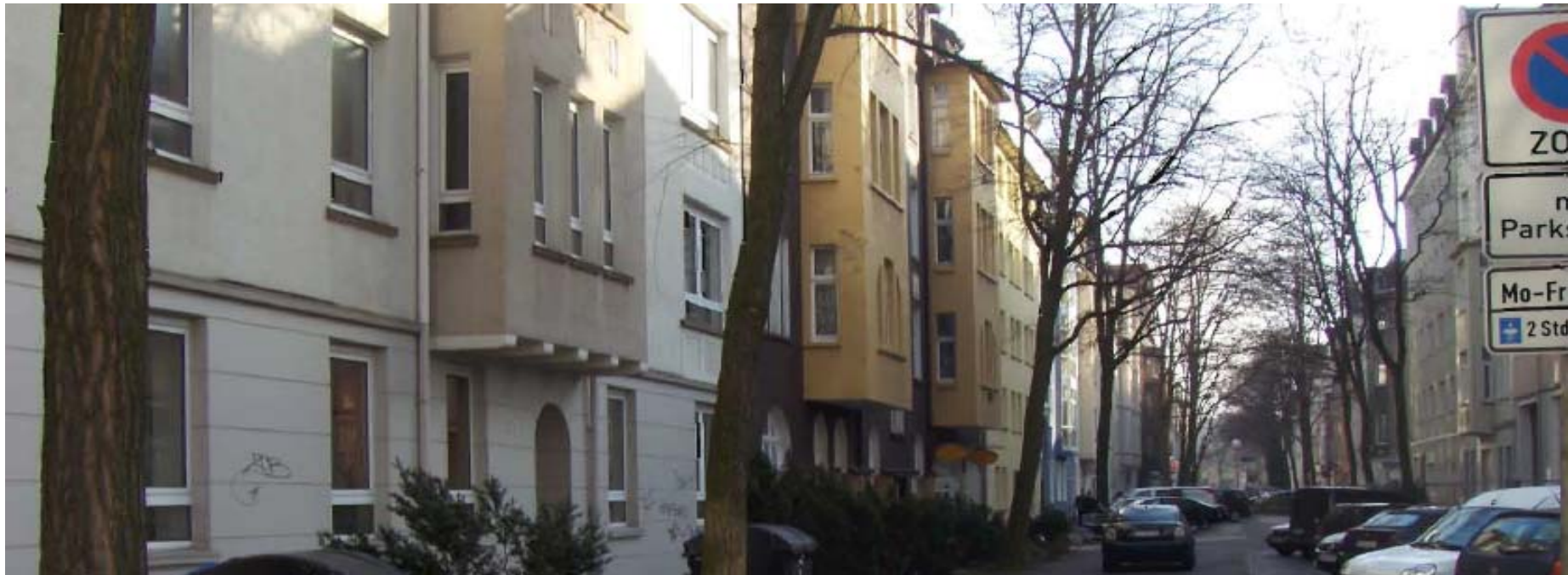
Sanierung Weser-Lutter, 16. Mindener Gespräch für den Tiefbau am 19.11.2015
