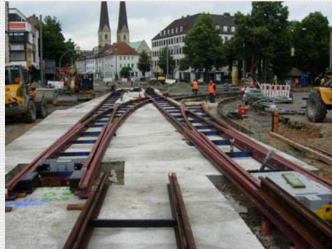
Umbau Detmolder Straße, Bielefeld | © STRABAG
