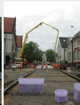
Umbau Detmolder Straße, Bielefeld | © STRABAG
