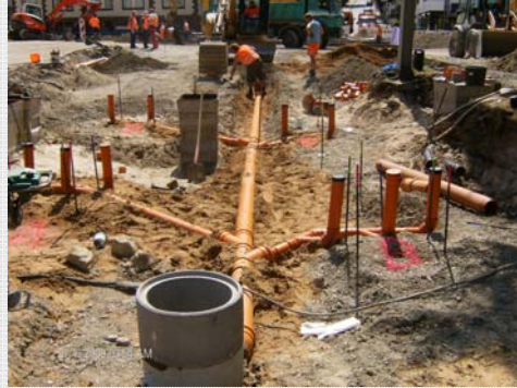
Umbau Detmolder Straße, Bielefeld | © STRABAG
