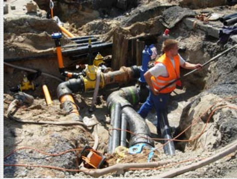
Umbau Detmolder Straße, Bielefeld | © STRABAG
