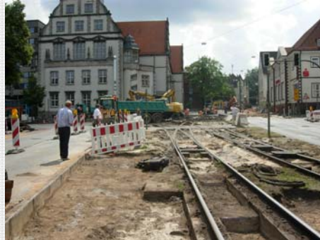
Umbau Detmolder Straße, Bielefeld | © STRABAG
