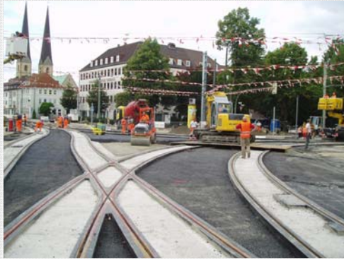
Umbau Detmolder Straße, Bielefeld | © STRABAG
