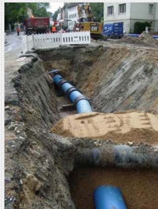
Umbau Detmolder Straße, Bielefeld | © STRABAG
