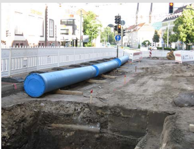
Hauptbauphase Auslegen der Hauptwasser- leitung ZW 600
