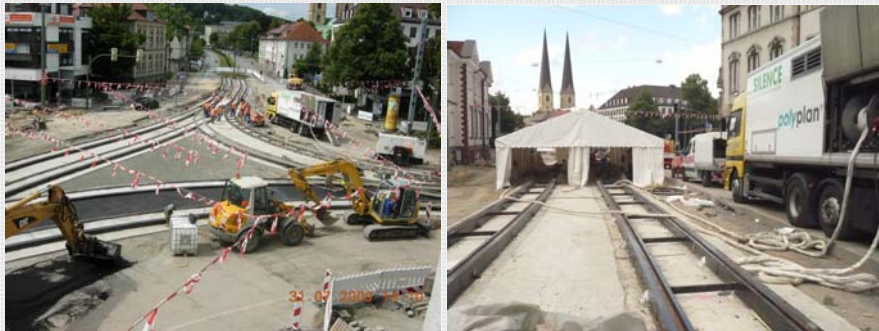
Umbau Detmolder Straße, Bielefeld | © STRABAG
