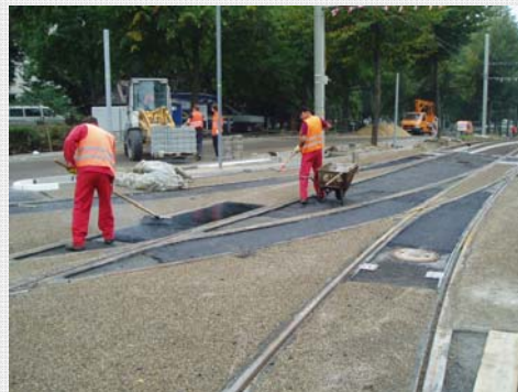
Umbau Detmolder Straße, Bielefeld | © STRABAG
