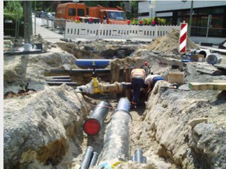
Umbau Detmolder Straße, Bielefeld | © STRABAG
