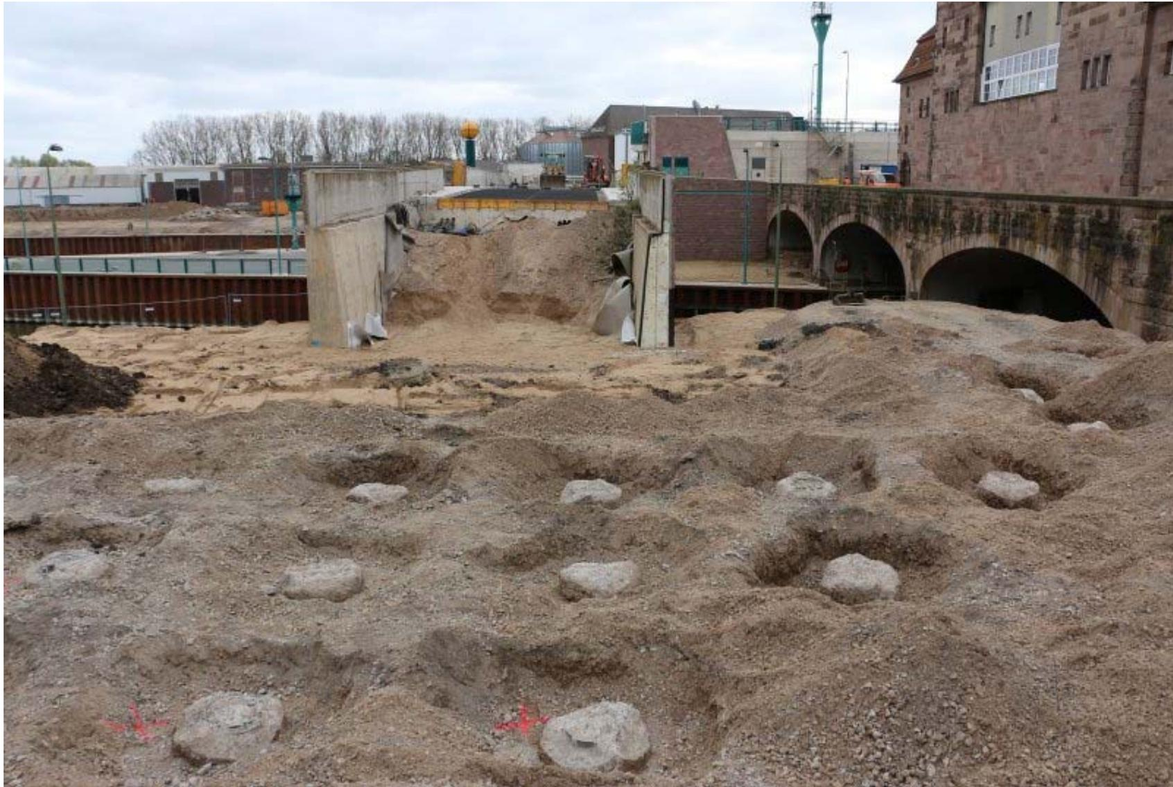
**Bohrpfähle als Baugrundverbesserung im Bereich der Brückenanrampung**
