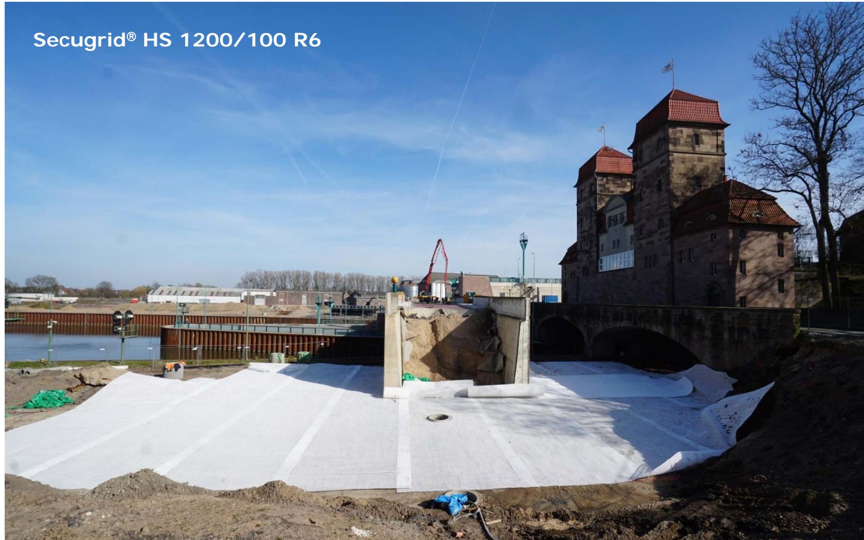
**Einbau Secugrid® HS (1. Lage, längs)**
