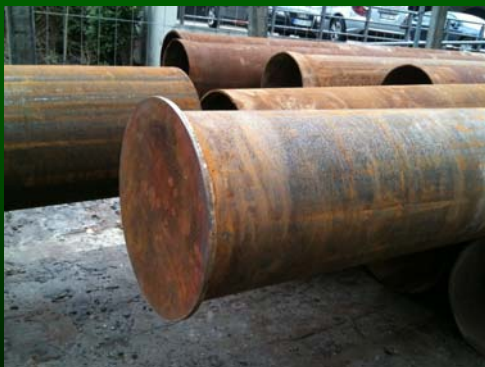
Pfahlfuß Innenrammung und Kopframmung mit Freifaller; bei der Kopframmung mit Schnellschlagbär spitz.
