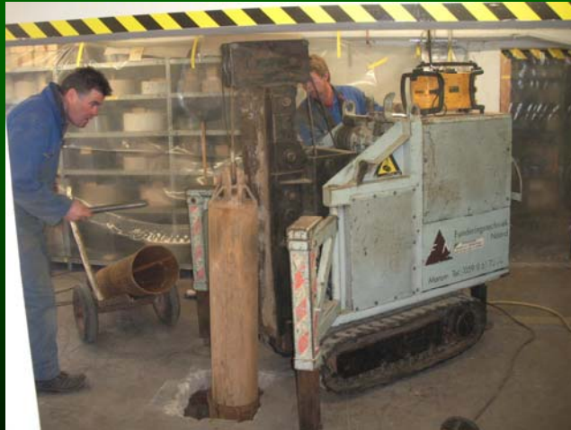
Umbau Werkhalle in Hamburg, sehr geringe Arbeitshöhe, 168mm + 219mm bis 9m
