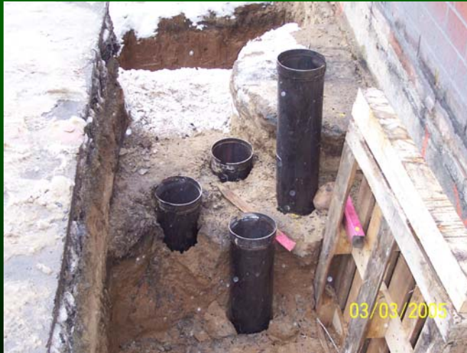
Aufstockung Silo, Fa. Bostik in Borgholzhausen Pfahlgruppe neben vorhandenem Fundament
