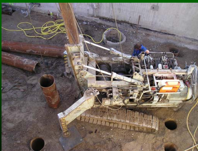
Aufstockung der Tiefgarage der Universität in Darmstadt unmittelbar neben der Universität, 45 Stück, Durchmesser 273mm und 324mm bis 13m
